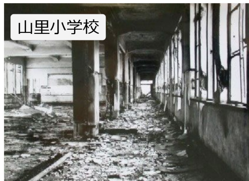
鉄筋コンクリート3階建ての「コ」の形 戦争が終わった後の山里小の中
