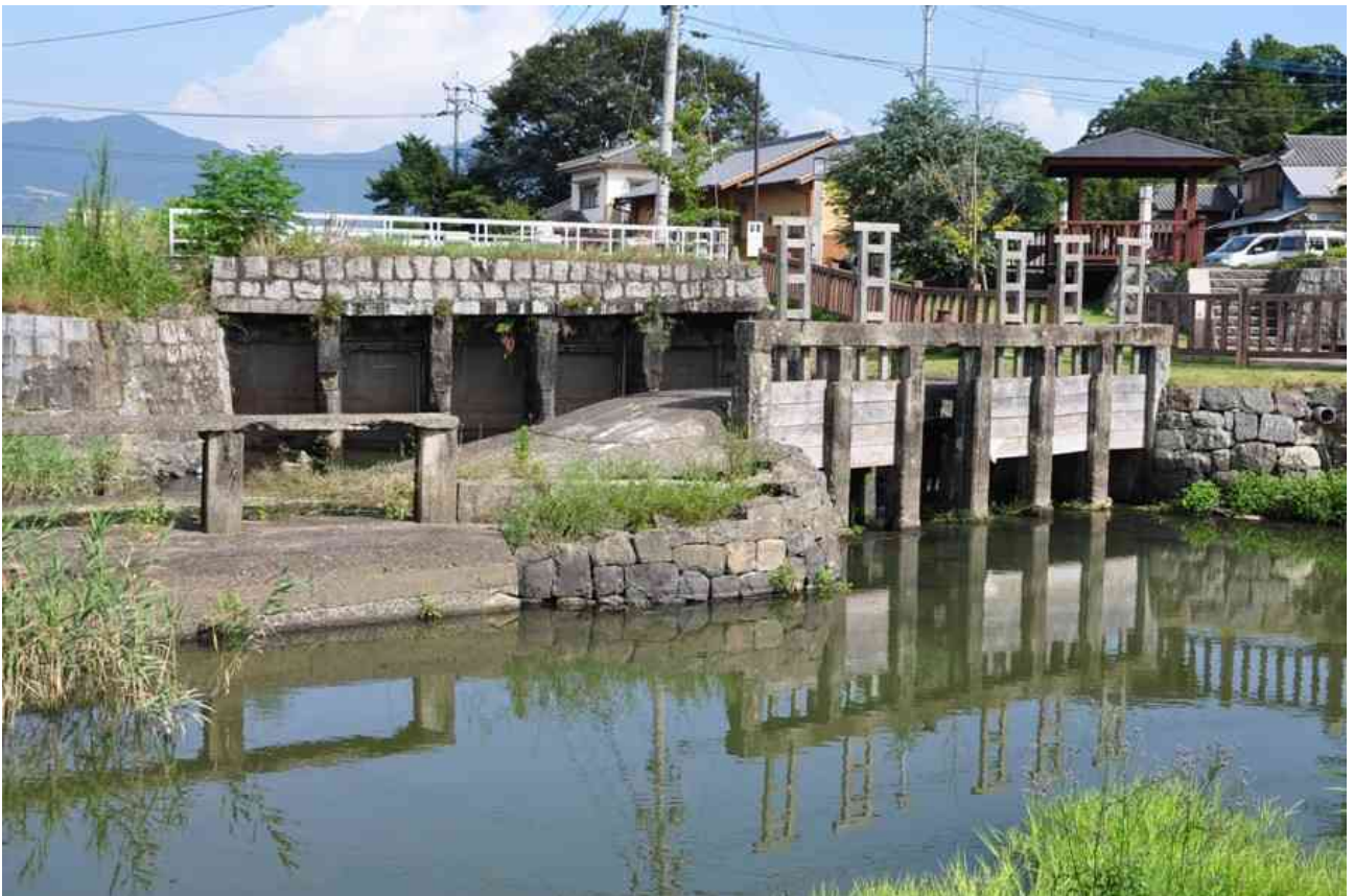
石塘の樋門群。奥が新内井樋、手前右が六枚井樋、左が越堰。
