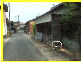
壊れかけた建物
