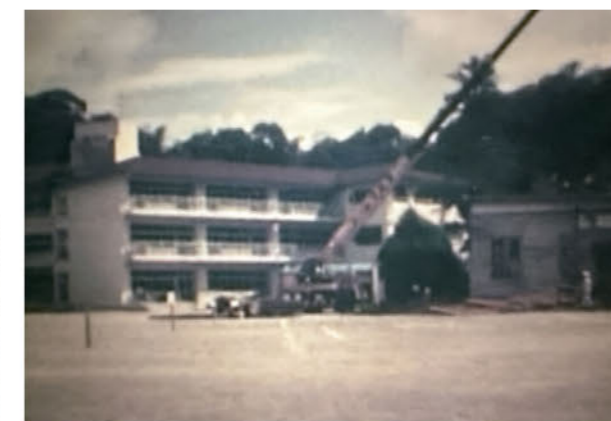
▲講堂（写真右）が解体される様子
