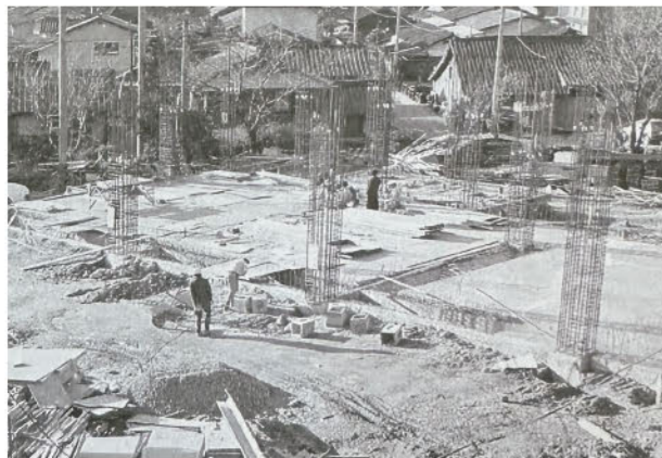
▲新校舎の建設
