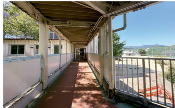
▲体育館への渡り廊下
