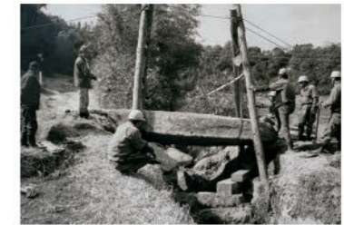
▲赤池水無町の天神溝に架かっていた石橋が、コンクリート橋に架け替えられることになり、記念碑用に搬出することに
