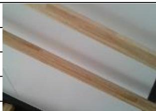
市役所の階段には、二重手すりがある。二重手すりには、歩行補助手すりと動作補助手すりがある。
