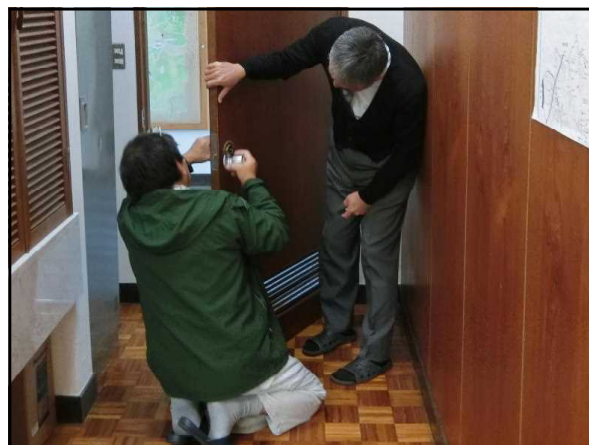
【校舎内の修繕「ドアノブ修理」：11月8日（金）】
