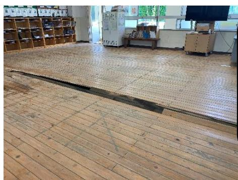
水が引き、乾き始めると、多くの個所で床が浮き上がり、棚板がはがれた場所も多く、張替え作業が行われています。
