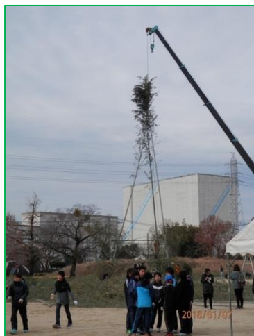
槽の組み立ては クレーン車を使用
