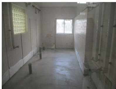
校舎1F西側児童トイレ改修
