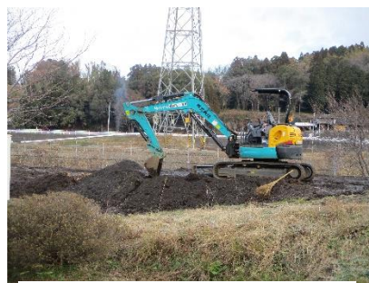
学校北側埋め立て
