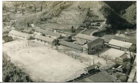
【懐かしの学び舎】 昭和47年頃の大畑小学校 航空写真
