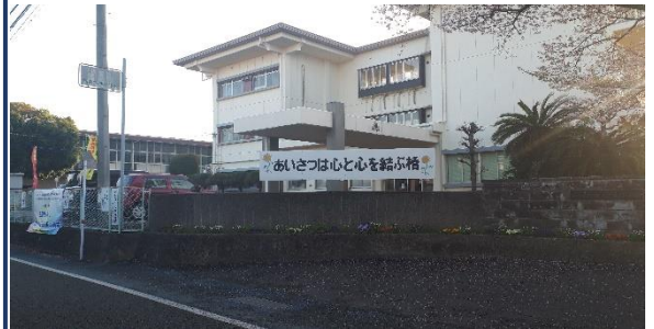
[正門横看板：あいさつは心と心をつなぐ橋]
