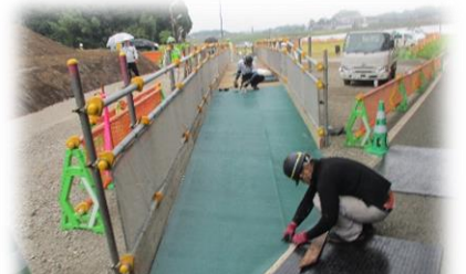
仮歩道の工事
