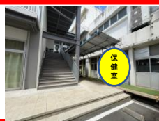
2F 職員室への 屋外からの階段
