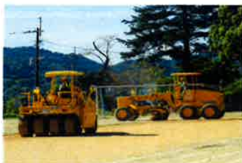
重機での作業
