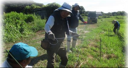
イノシシよけの電流線を設置するがまだす隊の方々
