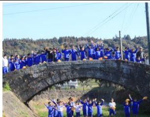
坂田橋（めがね橋）
