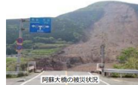
阿蘇大橋の被災状況
