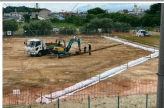
9月上旬排水用の管を埋設
