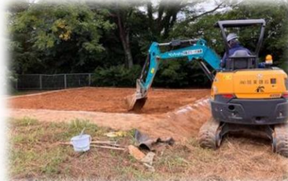
ひまわりファームの拡張工事を加来建設の方がやってくれました。ショベルカーであつという間にできあがりでした(9/5)
