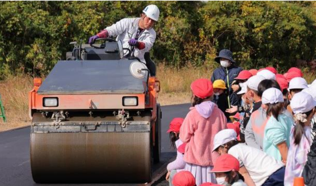
道路舗装の見学・体験
