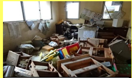
球磨村立渡小学校(浸水被害)
