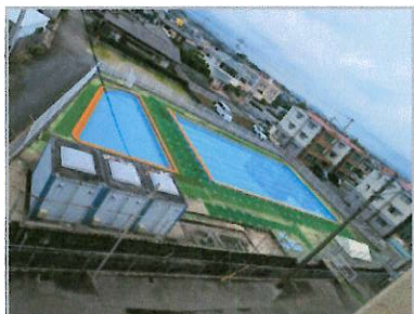
きれいになったプール
