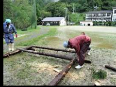
②長さをそろえた柱を、鳥居風に組み上げていきます。
