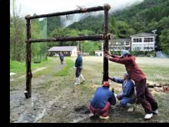
④組み上がった柱を立て、割矢(くさび)でしっかり固定します。
