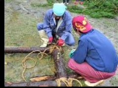
③釘などは使わず、荒縄で締め上げ、固定します。
