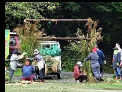
⑥柱に茅を巻き付けます。杉葉を差し込む土台になります。
