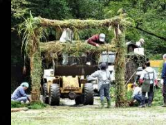
⑧巻き付けた茅を、わら縄で結わり、土台を締め上げます。
