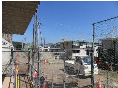
学校横の町営グラウンドに仮設住宅が60棟建設
