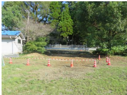
農具倉庫 → 解体・撤去
