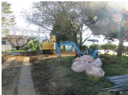
相撲場 → 解体・撤去
